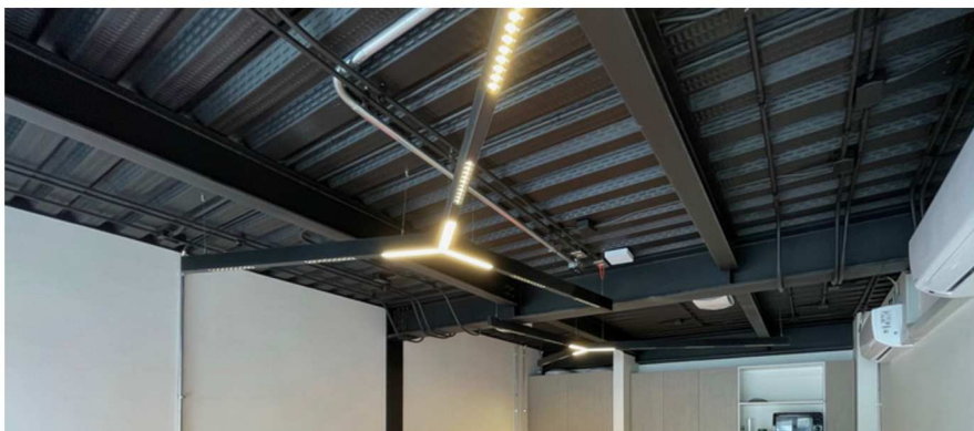
Centro de Investigación JRI Arquitectura: De Toro & Sitja Arquitectos
