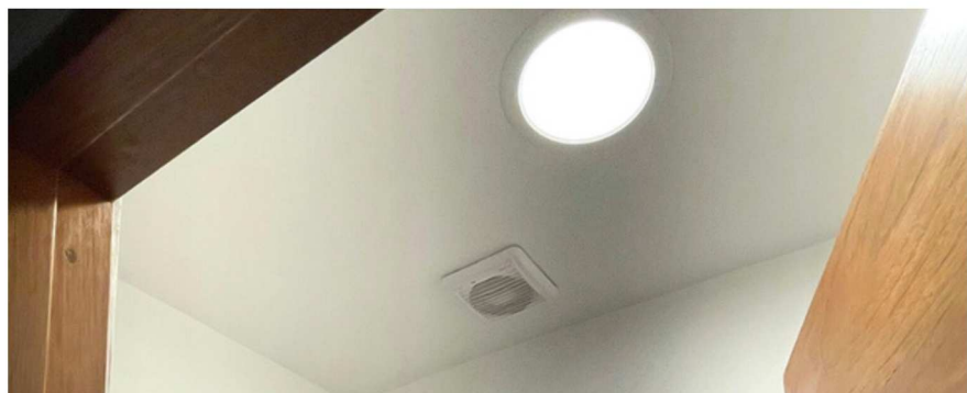
Oficinas BCI PAGOS Arquitectura: Collective Architecture
