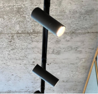
Showroom Multicompany Arquitectura y Diseño: OArquitectos.
