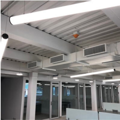
Oficinas MACAL. Arquitectura: Nicolas Arancibia Arquitecto.
